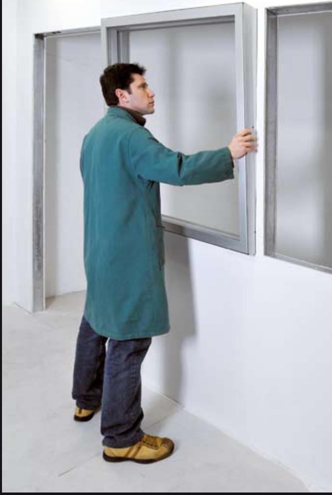
Inserimento del telaio in alluminio nel vano della parete in cartongesso.
