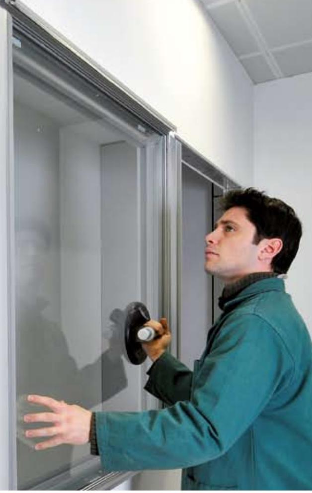
Inserimento del vetro nel telaio del modulo vetrato (visiva) e bloccaggio con le squadrette fermavetro.
