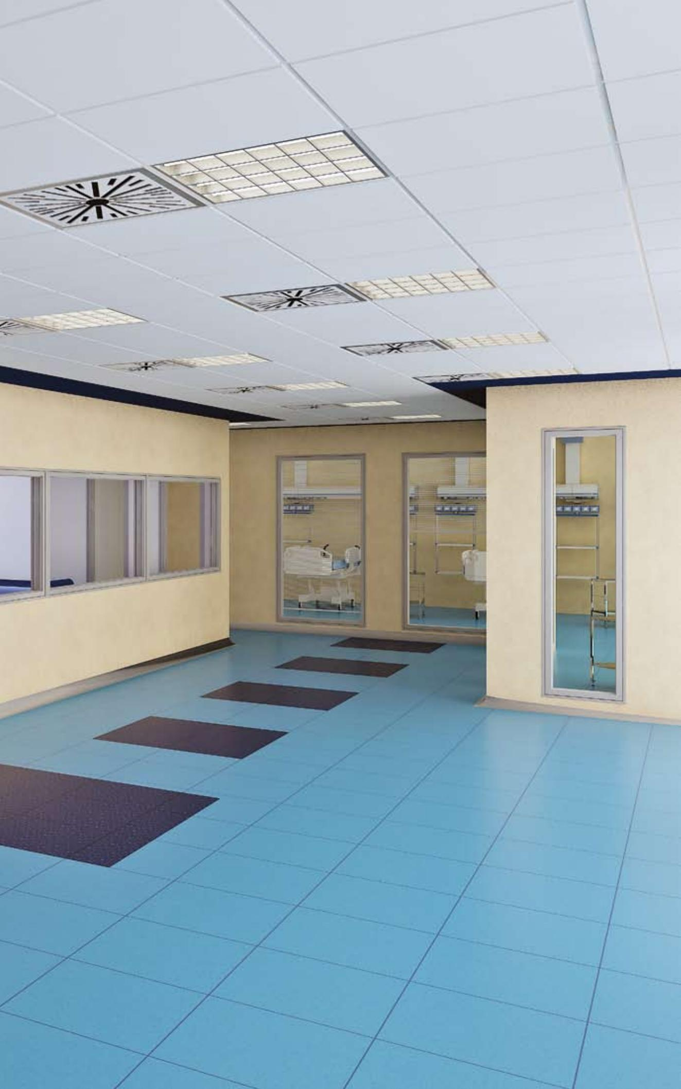
Moduli vetrati ad alto potere fonoisolante utilizzati in unità ospedaliera di terapia intensiva.
