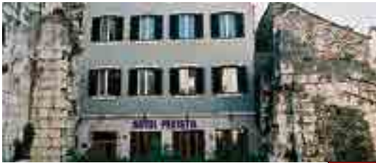
Hotel Peristil Split (Croazia)
